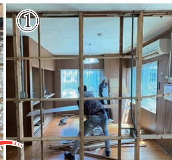
既存の壁を解体。
