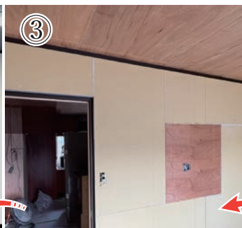
石膏ボードも重ね貼りし、 音が伝わりにくい壁へ。
