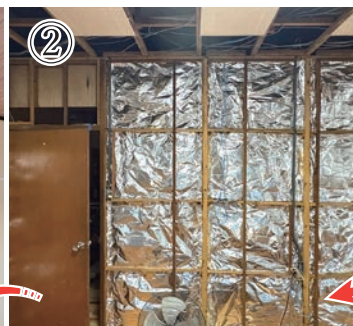
壁内部へグラスウールを施工 音を吸収しやすい構造に。
