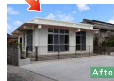
After ブロック塀と壁の一部を壊して間口を大きく 広々とした駐車場に
