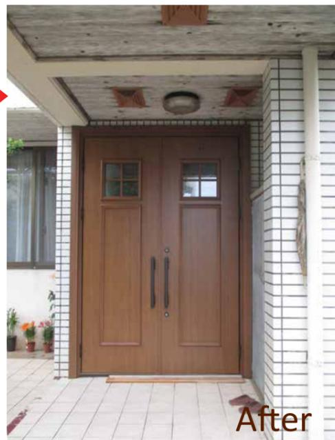
C様のお宅は築約30年の住宅。以前の玄関はラシマ付きの引き違い戸でした。年数が経ち、台風や強風の際には隙間風が吹き込んで、ドアがバタバタと揺れる状況でした。引き違いのドアから観音開きのドアへの取替えになりました。
