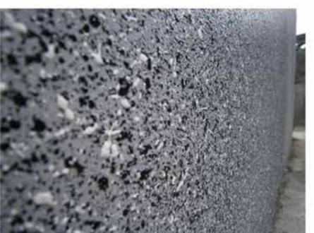
左官仕上げ・グレー下地・黒塗料模様吹き・ラフトン模様吹き・アクリルクリヤー仕上げ
