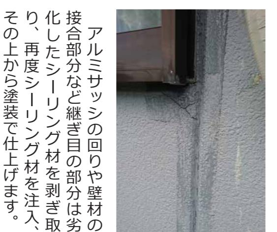
アルミサッシの回りや壁材の接合部分など継ぎ目の部分は劣化したシーリング材を剥ぎ取り、再度シーリング材を注入、その上から塗装で仕上げます。
