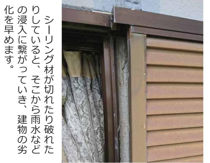
シーリング材が切れたり破れたりしていると、そこから雨水などの浸入に繋がっていき、建物の劣化を早めます。
